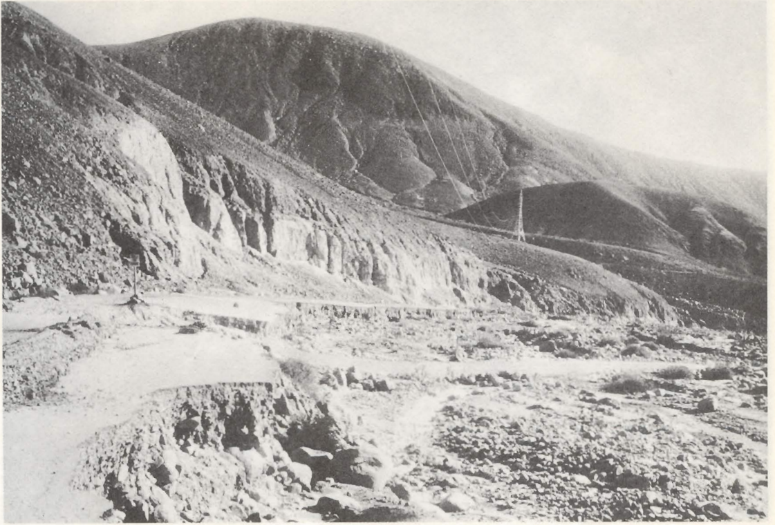
Fotografía 3: Quebrada Cardones. Disectamiento del camino hacia Bolivia por la avenida del año 1972.
